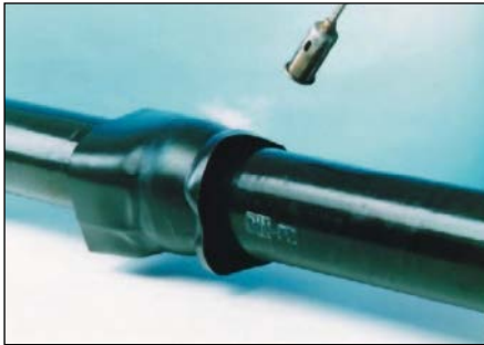
Bild 14.12: Applikation eines Schrumpfschlauches
